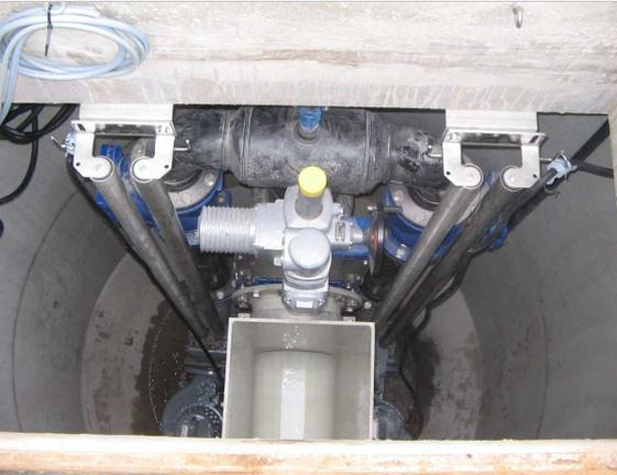
Hochwertiges Fertigteil-Schachtbauwerk DN 2000 - 3000.
